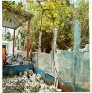
Foto 2: Vista de la intervención del muro lateral izquierdo donde se va a reforzar, por declive que esta presentando.
