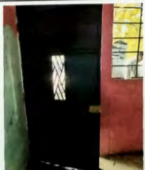
Foto 11: Vista de puertas de metal en aula donde se remozo la malla y se cambio la chapa en mal estado por chapa nueva.
