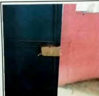
Foto 11: Vista de puertas de metal en aula donde se remozo la malla y se cambio la chapa en mal estado por chapa nueva.
