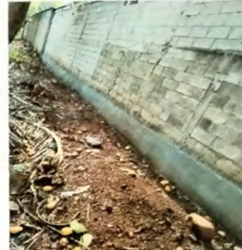
Foto 8: Vista de zocalo de alisado de cemento para impermeabilizar esa area y con ello evitar el ingreso de agua a las aulas.
