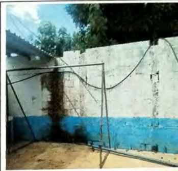
Foto 2: Vista de la intervención del muro lateral izquierdo donde se va a reforzar, por declive que esta presentando.
