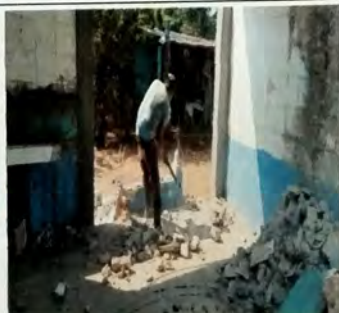
Foto 5: Vista de apertura de vano en muro para dar ingreso y egreso a los niños de preprimaria y con ello tener un mejor control.
