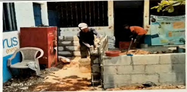
Foto 4: Vista de el muro de block pomes frente al modulo de aulas de preprimaria
