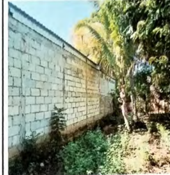
Foto 8: Vista de zocalo de alisado de cemento para impermeabilizar esa area y con ello evitar el ingreso de agua a las aulas.
